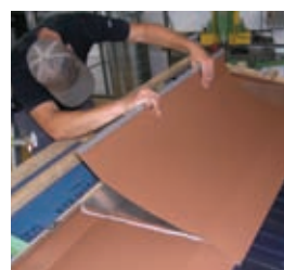
09 Installation de la bande de solin supérieure
