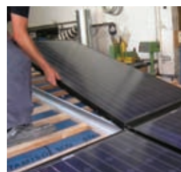
04 Installation et connexion des modules photovoltaïques
