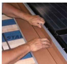
07 Installation de la bande de solin latérale
