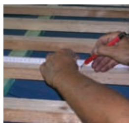
02 Marquage des positions pour les rails de montage
