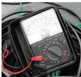
06 Vérification de la tension
