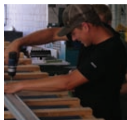
03 Installation des rails de montage
