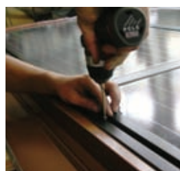
08 Installation des capotages et des bandes d'aluminium
