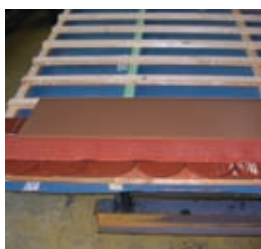
01 Installation de la bande de solin inférieure
